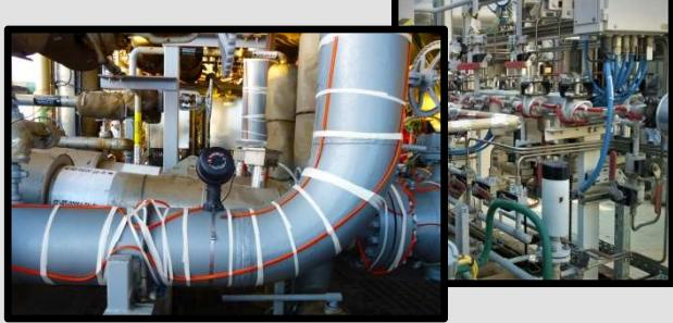
**Cavo scaldante a potenza costante per alte temperature**
